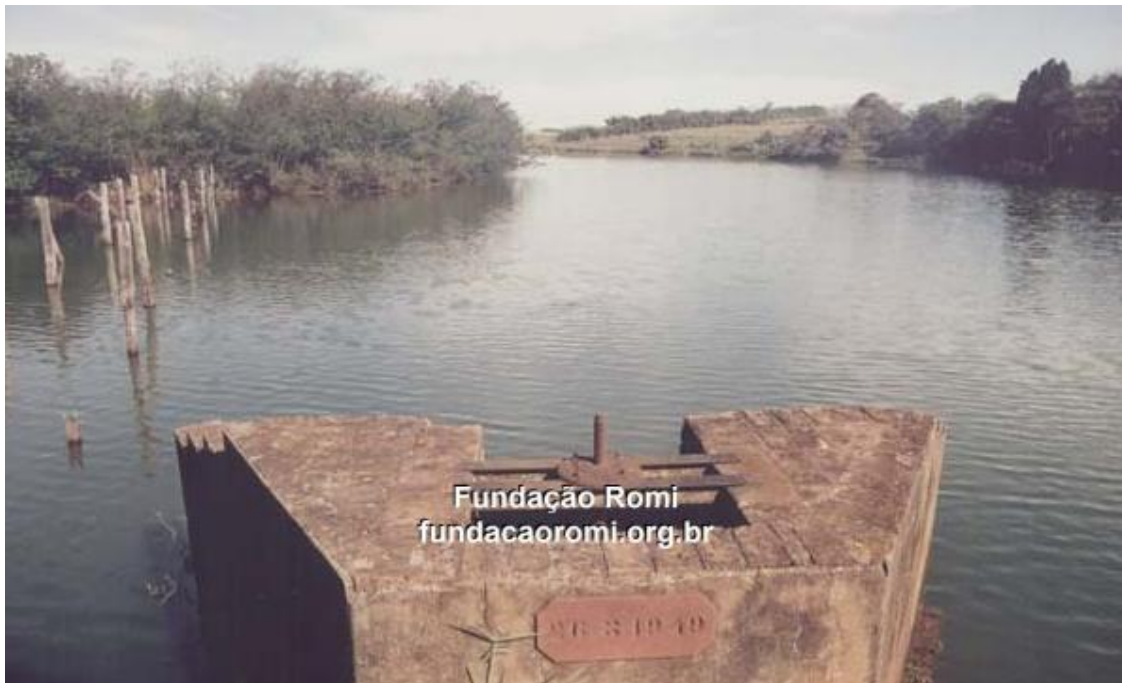
A “Represa de Água” que abastece a “Fazenda Galvão”
