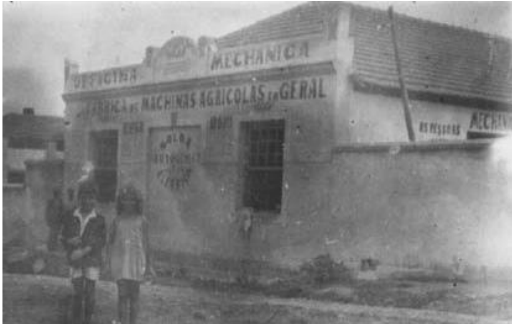
Este o prédio do “patriarca” Romi localizado na Rua General Osório (na frente, estão os seus filhos gêmeos – Romeu e Julieta Romi)
