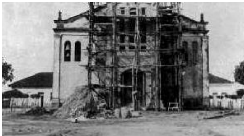
A torre sendo construída
