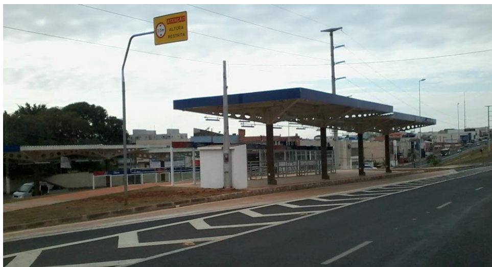
O “Corredor” passando pela estação de embarque e desembarque da extensa “Avenida São Paulo”
