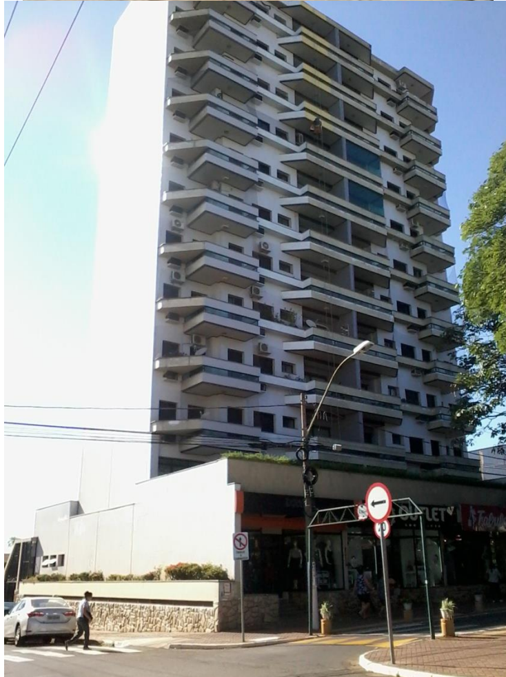
4 - Localização do “Edifício Ponta de Sol”: Rua Prudente de Moraes-Avenida de Cillo, esquina com a Rua Dona Margarida
