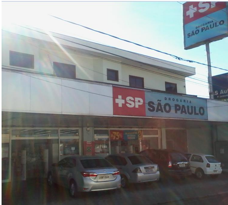
“Drogaria São Paulo”, localizada na Avenida Cillo, quase esquina com a Rua Riachuelo, centro
