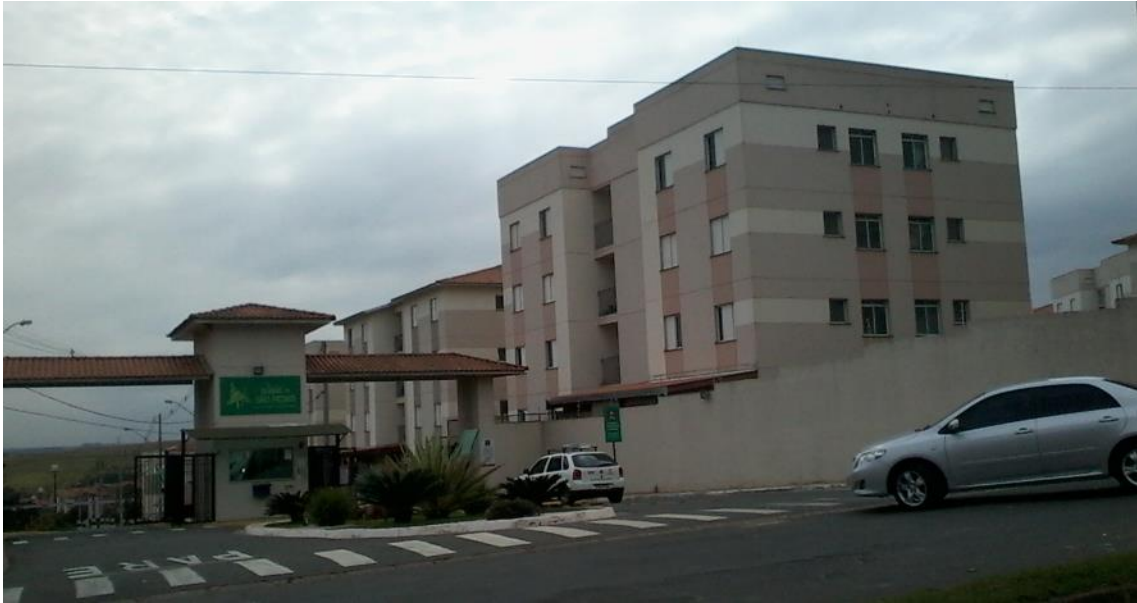
O “Condomínio Terras de São Pedro”, no Jardim das Laranjeiras
