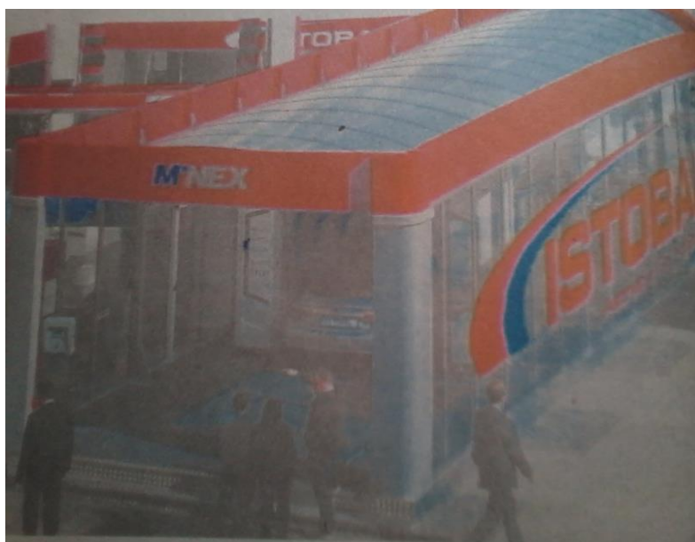
“Istobal do Brasil”, localizada na Rua Plínio Salgado, no “2º Distrito Industrial”
