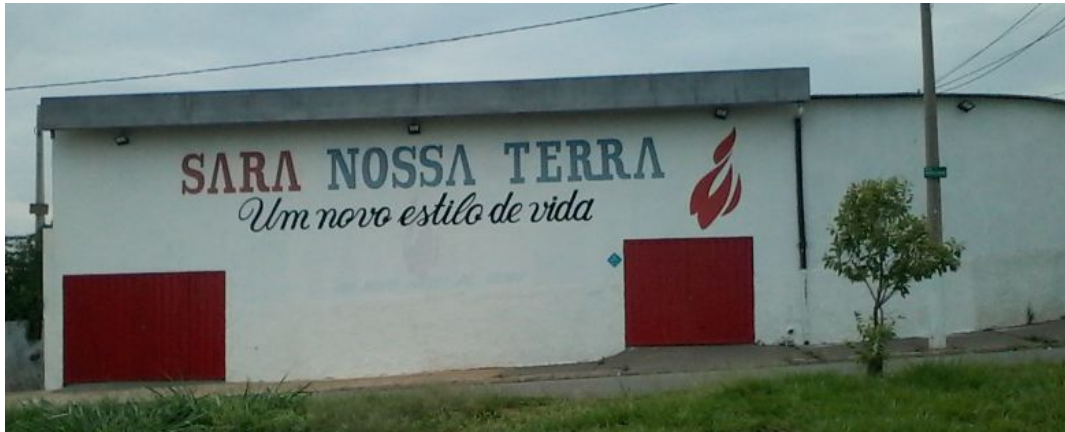
“Comunidade Sara Nossa Terra”, localizada na Rua Profeta Josué, na entrada do Jardim Laudissi II, zona sul
