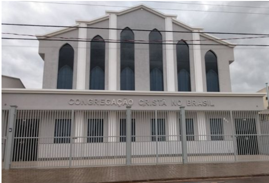
“Congregação Cristã no Brasil”, da Vila Brasil, localizada na Rua Bahia, zona norte (nova construção da igreja)
