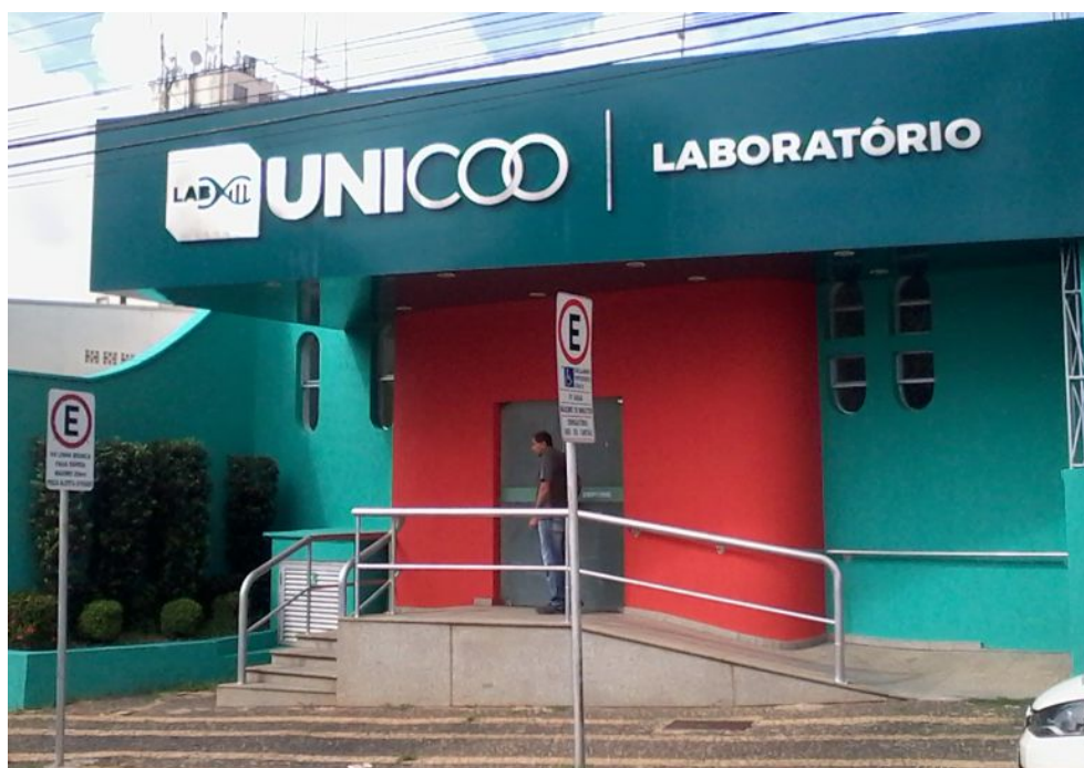
“Laboratório Unicoo – UNIMED”, localizado na Avenida Monte Castelo
