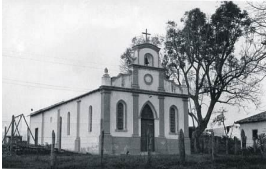
“Capela Santa Cruz”, da “Fazenda Areia Branca”, zona sul
