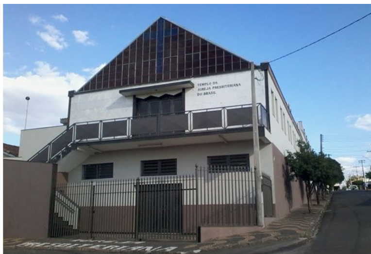
Templo da “Igreja Presbiteriana do Brasil”, localizada no Jardim América, na Rua Henrique Dodson, esquina com a Rua Camilo Augusto de Campos
