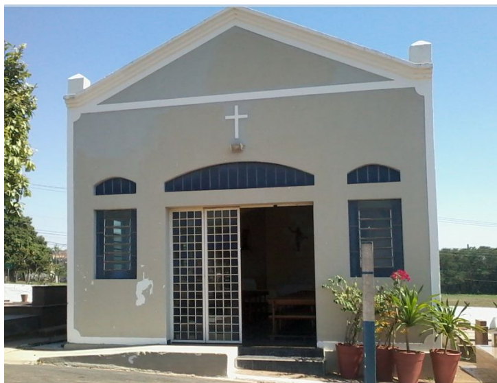
“Capela São Miguel Arcanjo”, no interior do “Cemitério Campo da Ressurreição” (o “Cemitério Central”)
