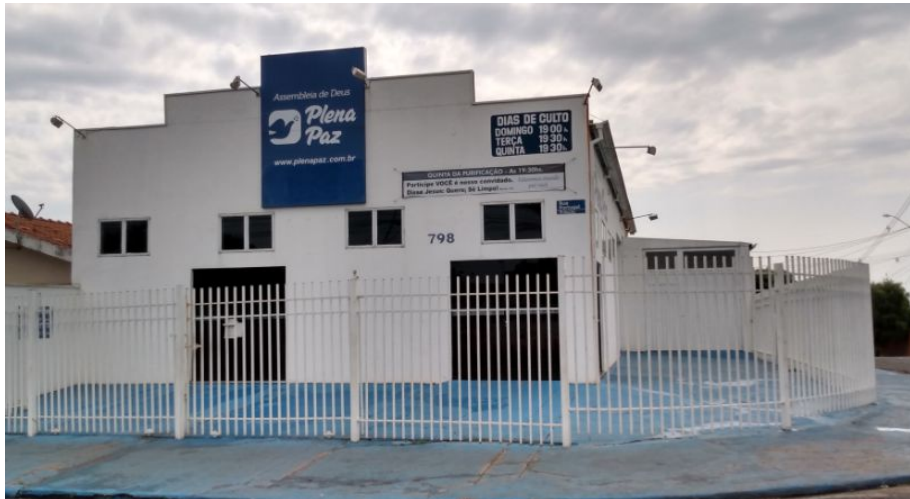
“Igreja Assembléia de Deus” (Plena Paz), localizada na Rua Portugal, no Jardim Europa, zona leste
