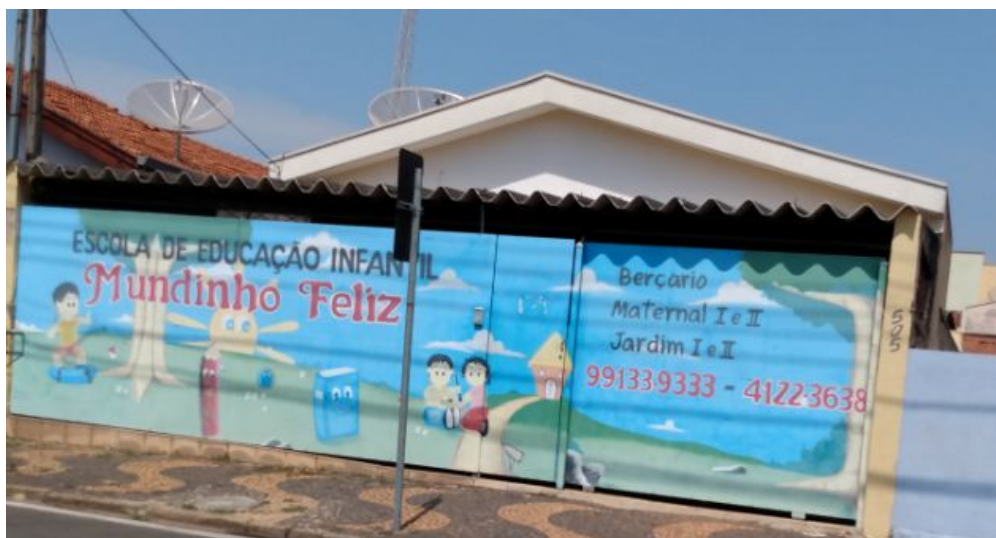
“Escola de Educação Infantil Mundinho Feliz”, localizada na Rua Goiânia, na Cidade Nova, zona leste
