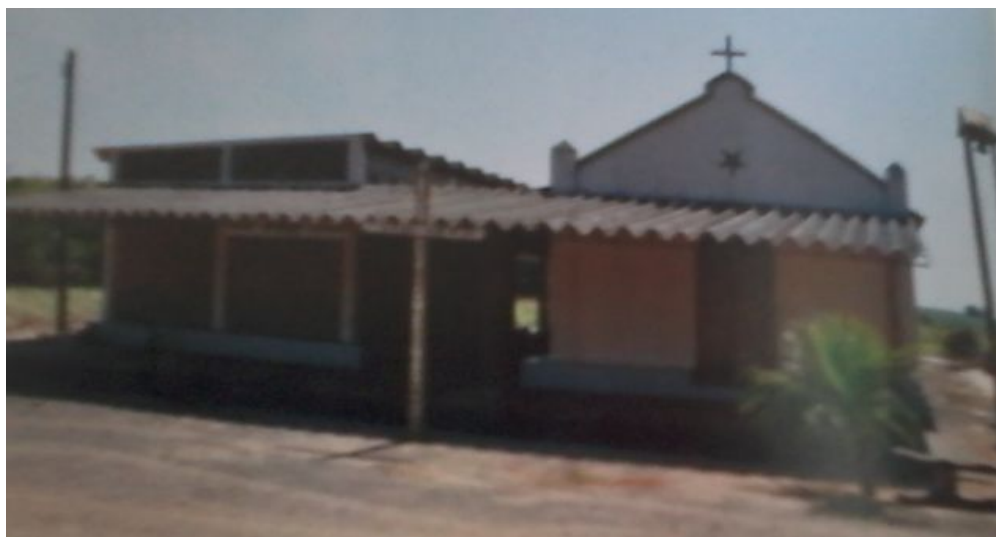
“Capela Santa Cruz”, do bairro rural “Olhos D’Água”, zona sul
