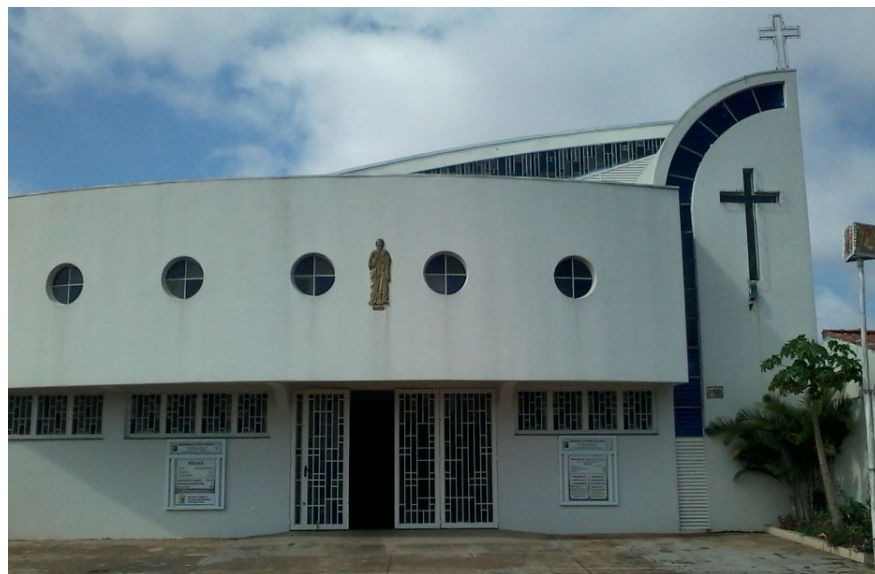
“Capela São Pedro Apóstolo”, localizada na Rua Bauxita, no Jardim São Fernando, zona leste
