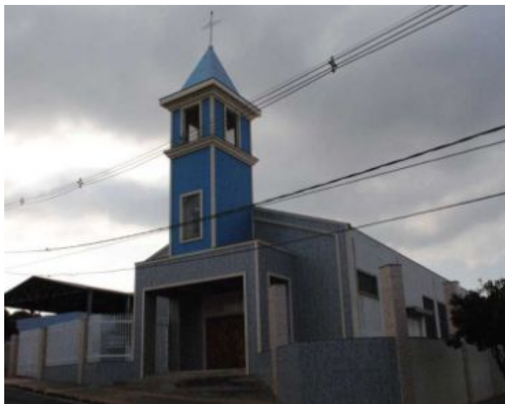
“Capela Santa Rita de Cássia”, da Vila Santa Luzia, zona oeste (inaugurada em 17 de setembro/1972)
