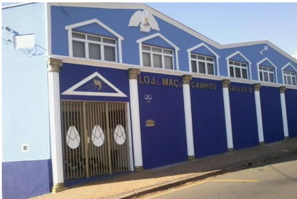
Aspecto atual da “Loja Maçônica”, no centro da cidade
